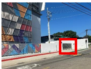
地下停車場入口
